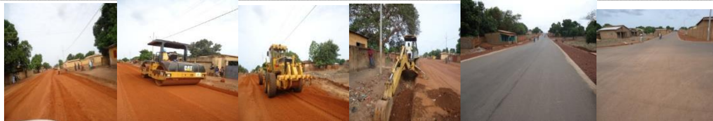
CONSTRUCTION DE COUCHE DE PLATEFORME ET COUCHE DE BASE - BITUMAGE ET BORDURE DE CHAUSSEE - HAUTE GUINEE
