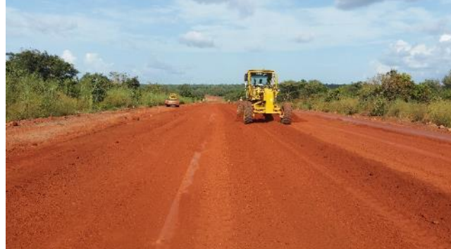
MISE EN PLACE DE COUCHE DE BASE
