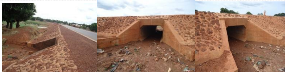
DALOTS ET TALUS - PERRE MAÇONNE - HAUTE GUINEE
