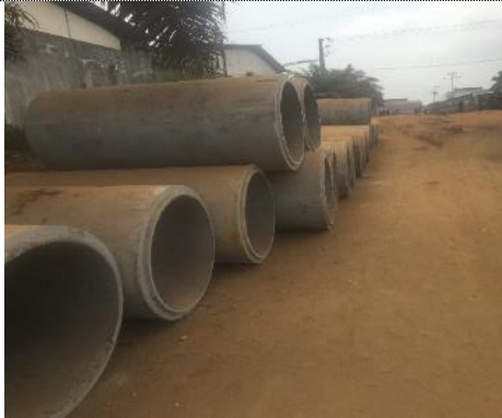
APPROVISIONNEMENT BUSES ASSAINISSEMENT - ROUTE KANKAN-MANDIANA
