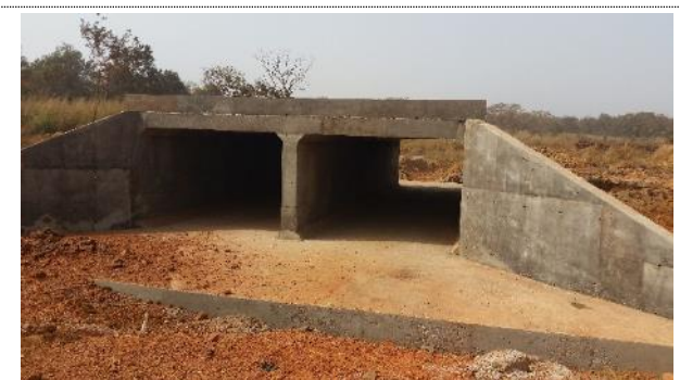
CONSTRUCTION DE DALOTS
