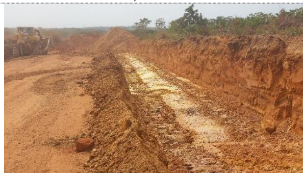
FOUILLES ET EXUTOIRES EN TERRAIN MEUBLE
