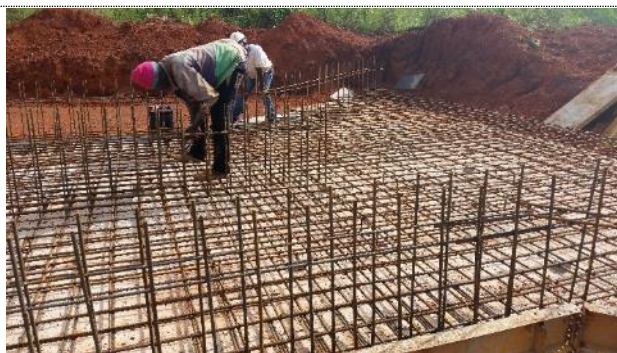
FERRAILLAGE ET COULAGE DE DALOTS
