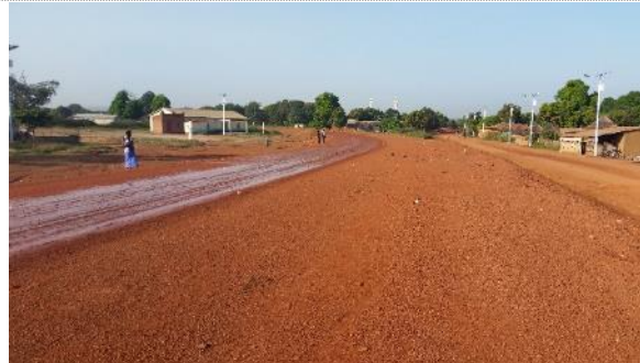
TRAVAUX D'ASSAINISSEMENT, DE REPROFILAGE ET DE RECHARGEMENT
