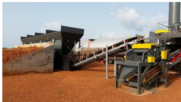
CONTRÔLE CENTRALE D'ENROBES
